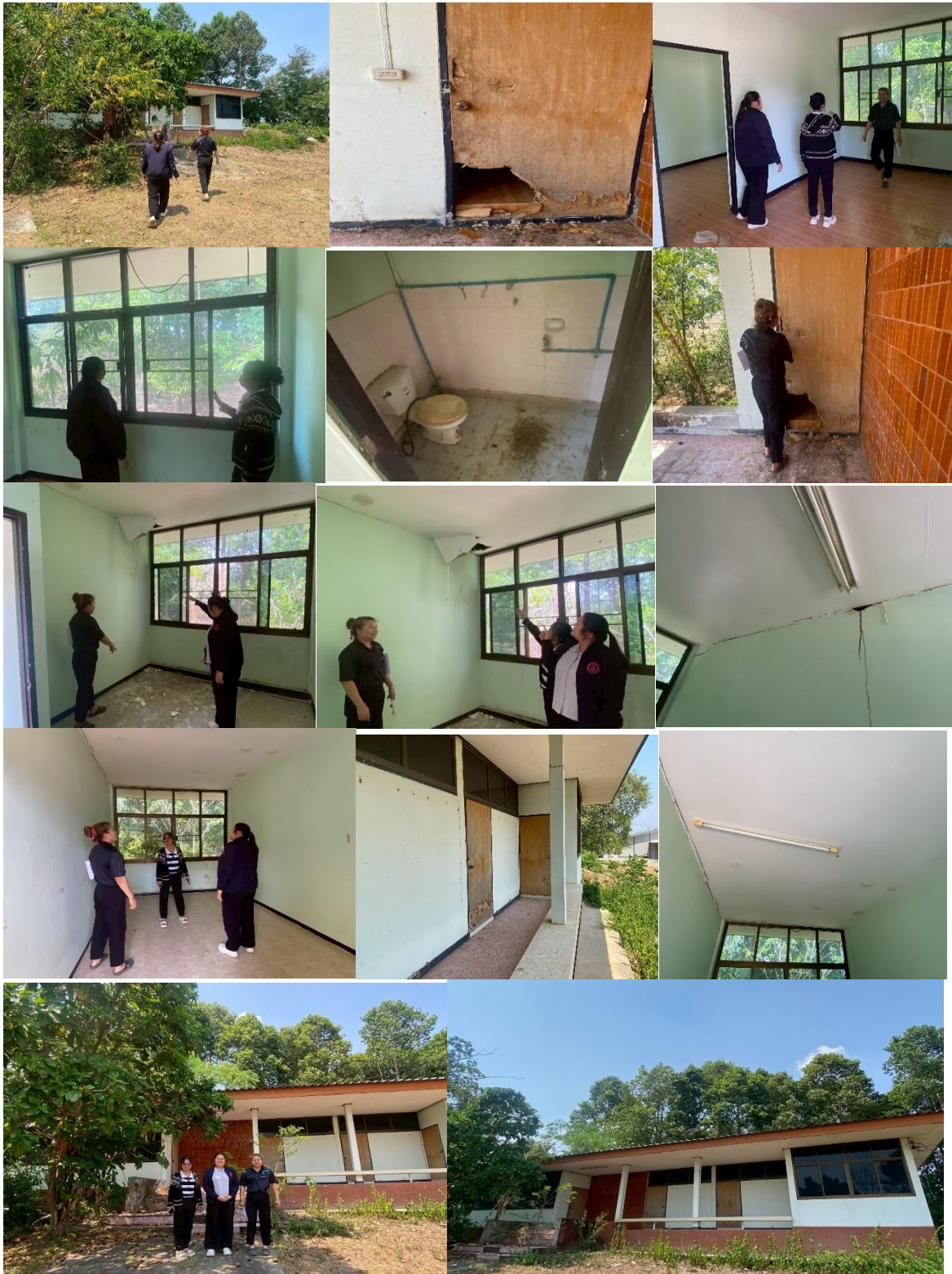
อาคารหมายเลข ๐๓ บ้านพักรับรองคอนกรีต จำนวน ๑ หลัง
